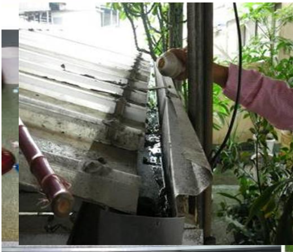
天溝(屋簷排水槽)
