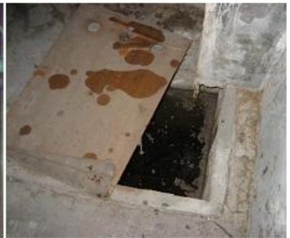
地下室污水池
