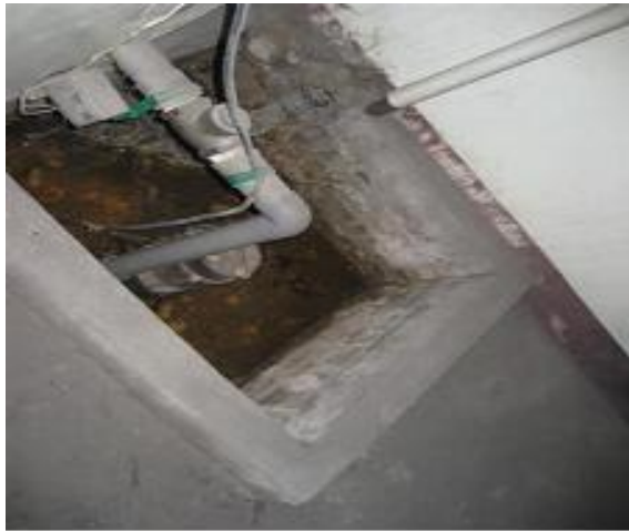
地下室儲水槽
